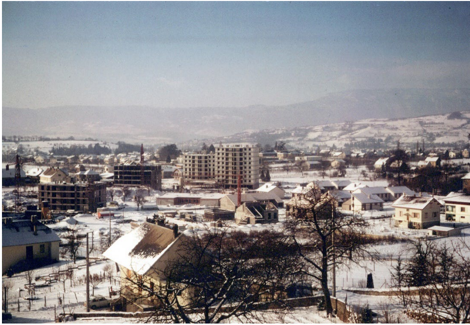
Vue d'ensemble du Clos Besson : immeubles en cours de construction, mai 1971, Père Durand (1Fi148/1)
