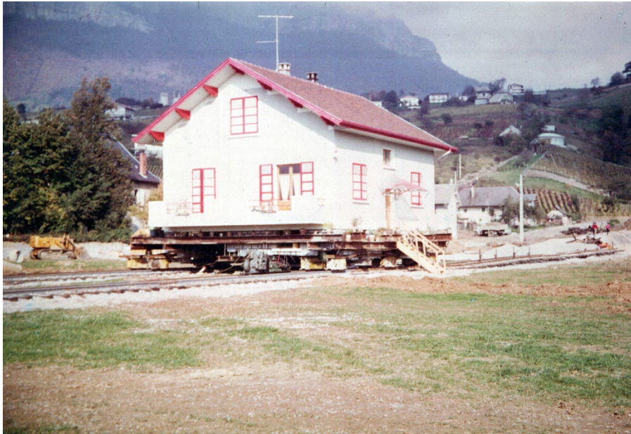
Construction du Clos Besson, déplacement des maisons : maison "la Désartière" en cours de déplacement sur rails, janvier 1969 (1Fi147/3)
