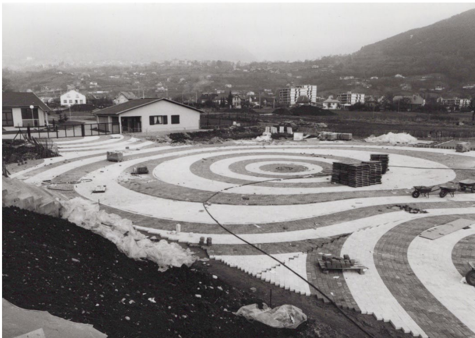
Construction de la place des Epinettes, sans date (1Fi70/2)
